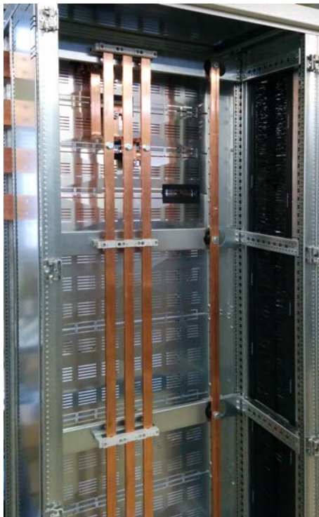
Blick auf F-SaS bis 630 A H-SaS oben
