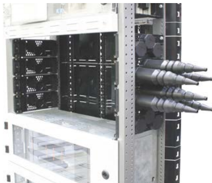
Leistenführungen und Kabelschottungen; vorbereitet zum Einbau von LL, sasil-Leisten
