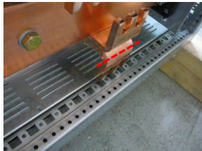
Zuschnitt des Anschlusswinkels L1
