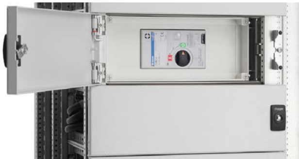
tembreak2 auf Modulträger PCC montiert, mit Abdeckung, bedienbar hinter der Tür
