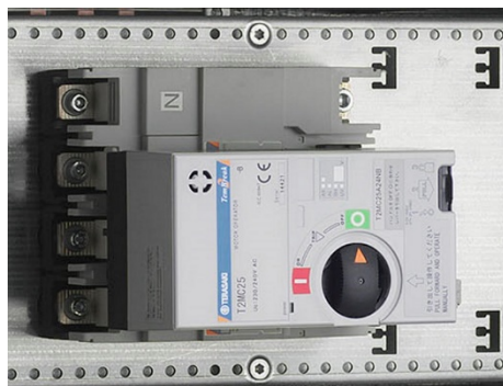
tembreak2 mit Motorantrieb, bedienbar hinter der Tür
