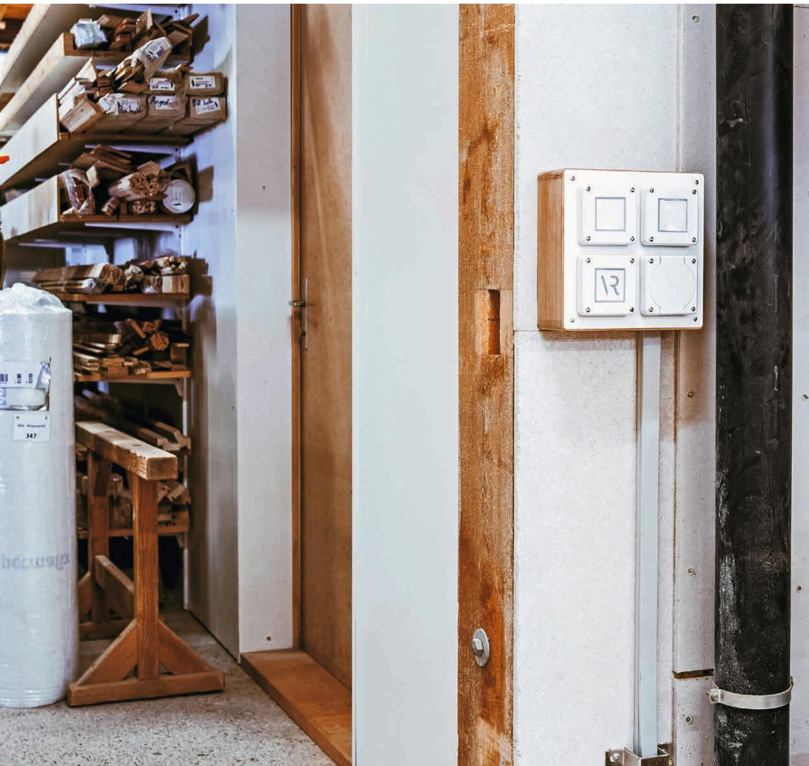
Les nouvelles plaques de montage et les nouveaux boîtiers apparents conviennent pour des applications plus complexes avec plusieurs fonctions. Les plaques de montage sont disponibles dans les quatre couleurs standard robuste et combinent jusqu'à 16 appareils.
