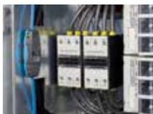
Groupe de raccordement pour le montage du convertisseur avec mesure du propre courant pour concept d'entretien et de sécurité. Les câbles d'alimentation sont raccordés directement à l'horizontale aux jeux de barres à l'aide de vis M12.
