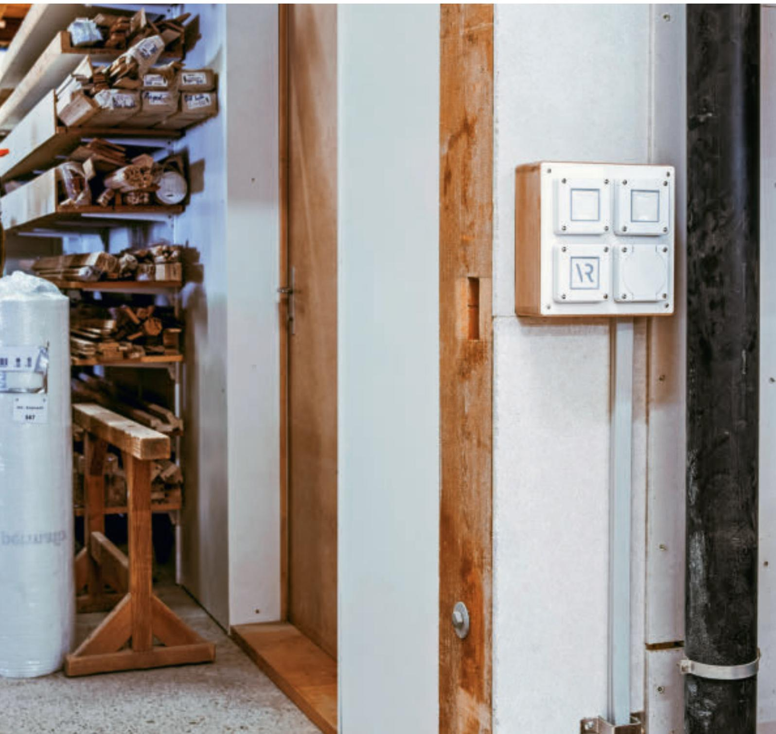
Les nouvelles plaques de montage et les nouveaux boîtiers apparents conviennent pour des applications plus complexes avec plusieurs fonctions. Les plaques de montage sont disponibles dans les quatre couleurs standard robusto et combinent jusqu'à 16 appareils.
