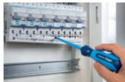
Le peigne de raccordement peut aussi être enlevé facilement d'un simple mouvement de levier
