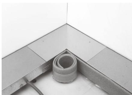
10. Pose de la bande isolante sur la paroi du canal côté chape (veiller à ce que la chape ne coule pas sous le canal). Respecter les mesures particulières à prendre en cas d'utilisation de chapes liquides, chauffées ou agressives. Suivant le revêtement utilisé (p. ex. matériau liquide), il faudra consulter le fabricant. Si une autre bande isolante est nécessaire sur la paroi du canal côté mur, elle doit être posée avant d'effectuer l'étape de montage n° 4.
