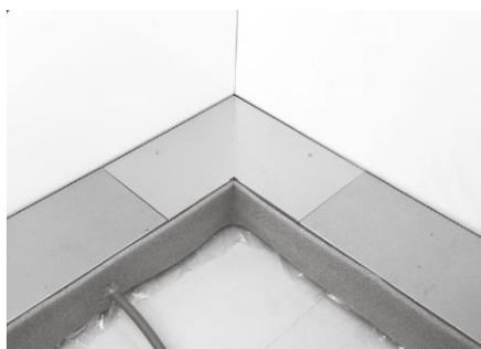
11. Soutenir au besoin la paroi du canal côté chape, afin d'éviter toute déformation de la paroi suite à la pression de la chape. Le monteur qui réalise la chape doit l'ajuster proprement jusqu'au niveau de l'arête supérieure du canal. Veiller à ce que la chape ou des parties du revêtement de sol (p. ex. matériau liquide) ne pénètrent pas dans le canal.
