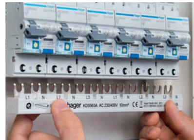
Schnelle und sichere Abgangs- und Eingangsverdrahtung dank innovativer Stecktechnik – Stecken statt Schrauben. [Seite 20](#)
