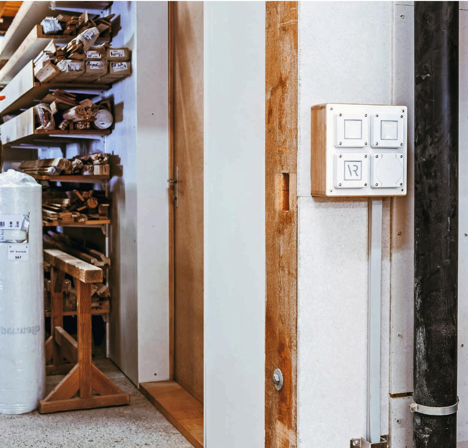
Die neuen Montageplatten und AP-Gehäuse eignen sich für komplexere Anwendungen mit mehreren Funktionen. Die Montageplatten sind in allen vier robusto Standardfarben erhältlich und kombinieren bis zu 16 Apparate.
