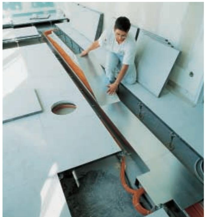
*Mit den passenden Formteilen und abgestimmtem Montagezubehör kann das FWK System auch perfekt im Boden installiert werden.*
