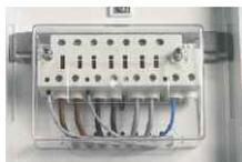
Vorbereitete Zählersteckklemmen lassen sich mittels Abdeckhaube sicher plombieren.
