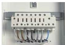
Einfacher Spannungsabgriff durch integrierte Zusatzklemmen für ungezählten Spannungsabgriff L1, L2, L3 und N, z.B. für die Steuerung
